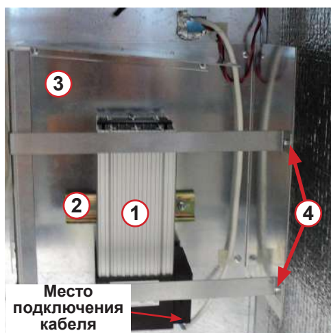
Рисунок 8 - Установка датчика температуры и нагревателя
